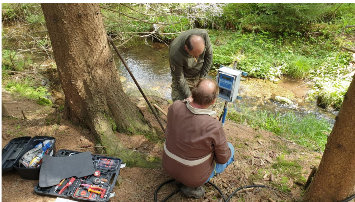
Obr. 20 Montáž automatické stanice na Slučím potoce
